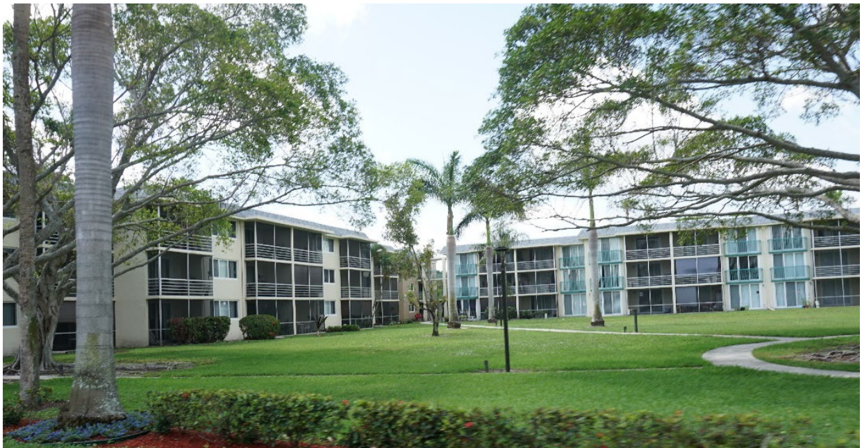
Lake Delray - Post Rehab Exterior
